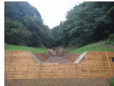
木製床固工、木製水路工 (米代西部署)
