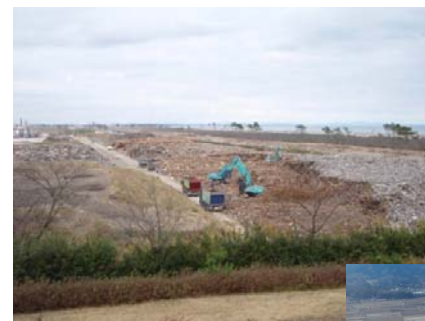
がれき置場として貸付している国有林野（仙台市）
