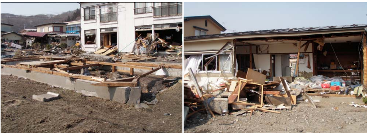
津波により全壊した三陸北部署の宿舍（岩手県宮古市）
