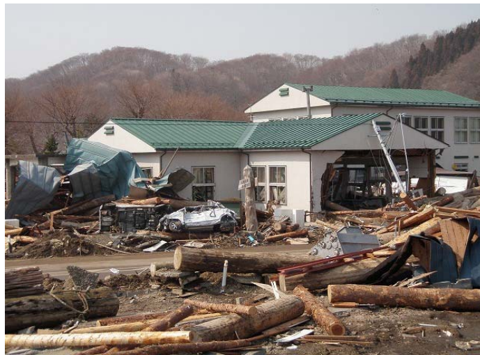
津波により全壊した三陸北部署の庁舎（岩手県宮古市）
