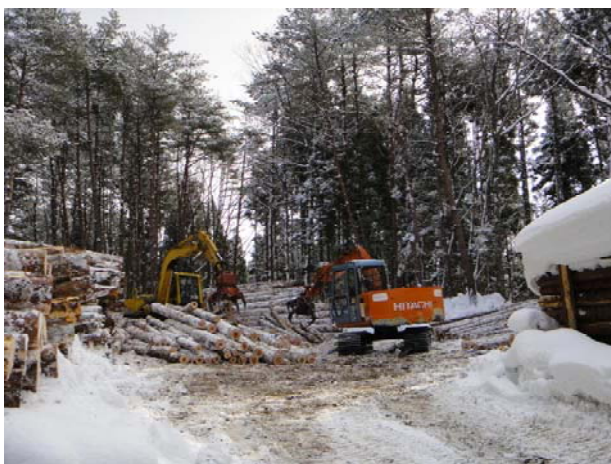
山元土場での作業状況（青森県東北町）
