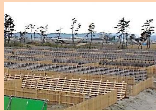
生育基盤造成工完成箇所
