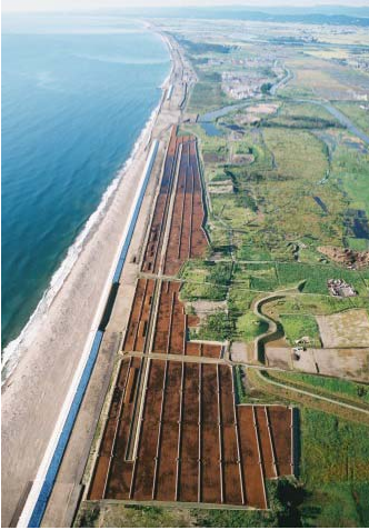
生育基盤造成工(岩沼地区)
