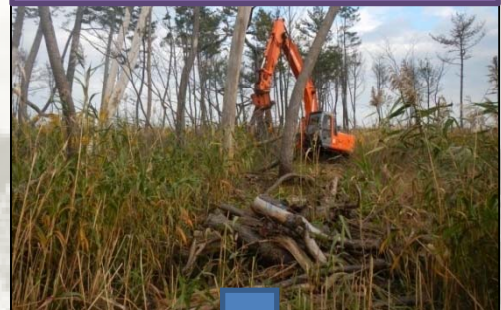
被災木の撤去
