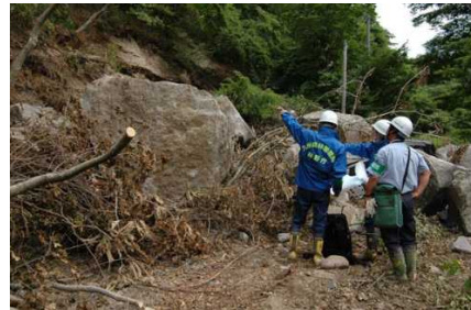
全国から派遣された森林管理局等の 治山技術者による現地調査 (平成20年岩手・宮城内陸地震)
