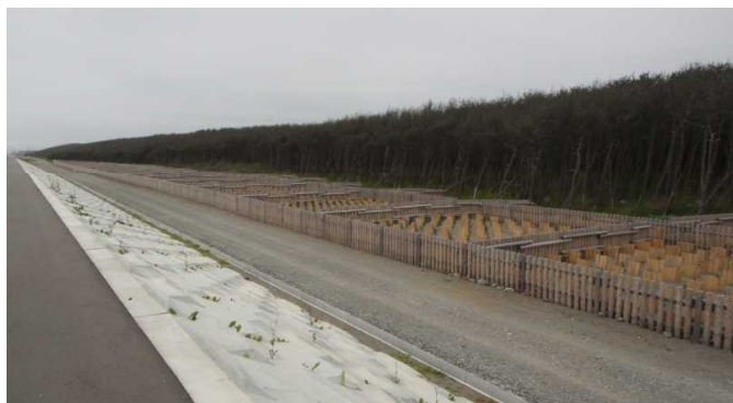
海岸林復旧工事への杭材供給 (三沢市・民有林)
