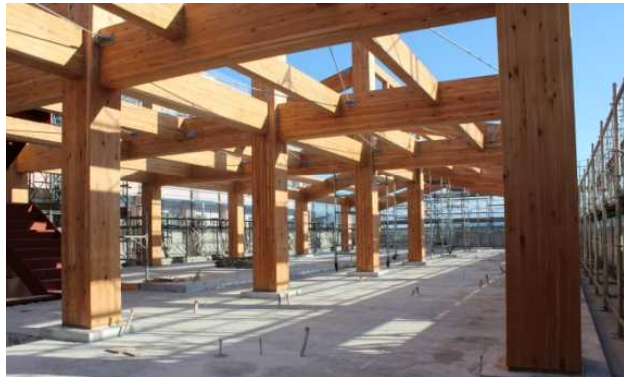
大断面集成材を使用した新庁舎の躯体 (三陸北部署新庁舎)
