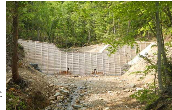
木製残存型枠を使用した 治山事業 (青森署)
