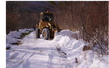
林道の除雪（遠野支署）
