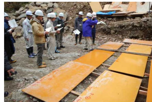
国産材を使用した合板型枠 試験施工の様子 (山形署管内)
