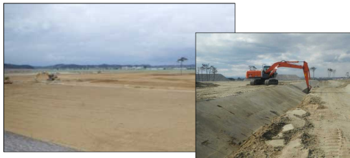
生育基盤盛土を造成
