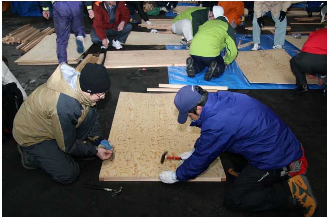
パネル表面の製作
