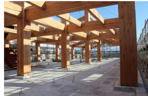
大断面集成材を使用した新庁舎建設の様子 (三陸北部森林管理署新庁舎)
