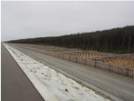
海岸林復旧工事への杭材供給（三沢市・民有林）
