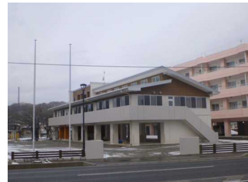
完成した新庁舎全景 (三陸北部森林管理署新庁舎)
