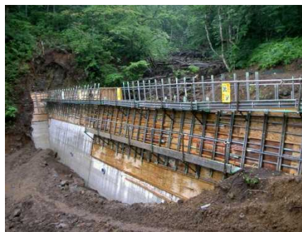
国産材型枠合板を一部活用した治山工事 (山形市)
