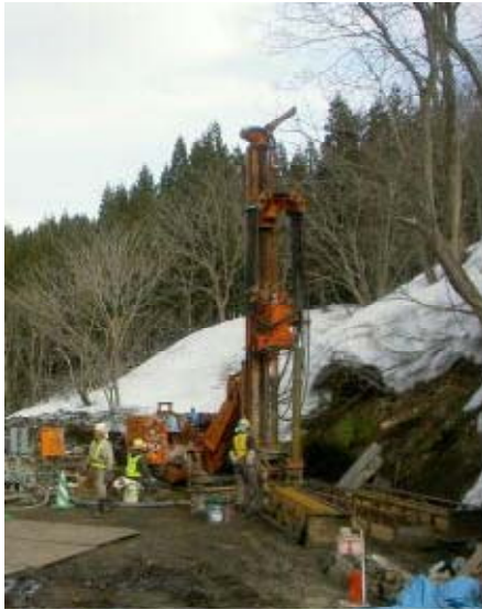
地上から立体排水トンネルに向けた落込ボーリングを施工
