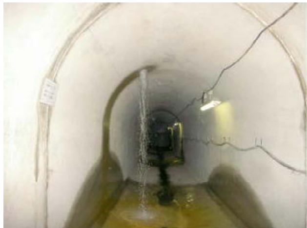
立体トンネル内に排水される様子
