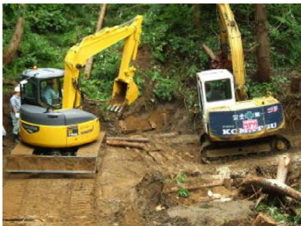
排水処理のため水路を作設
