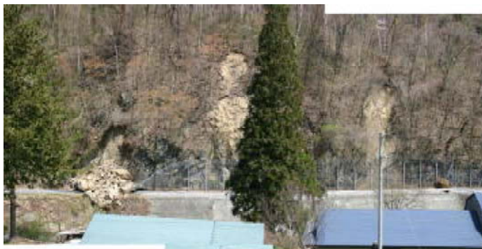
法面工事の施工前
