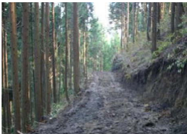
完成した低コスト作業路
