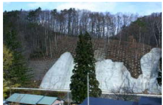
法面工事の施工後
