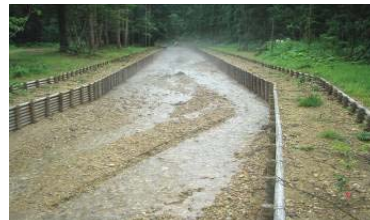
溪流生態系に配慮した工法のイメージ (秋田県大館市)
