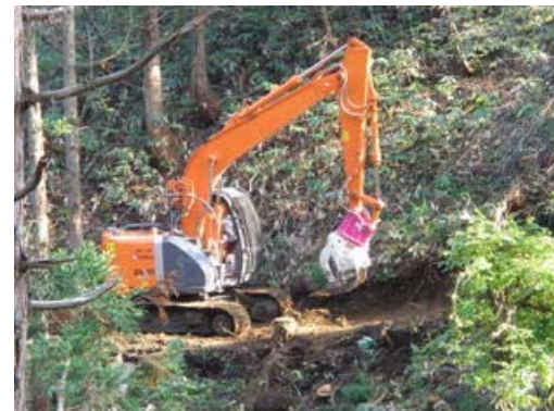
低コスト作業路作設の様子 (山形県(最上支署))
