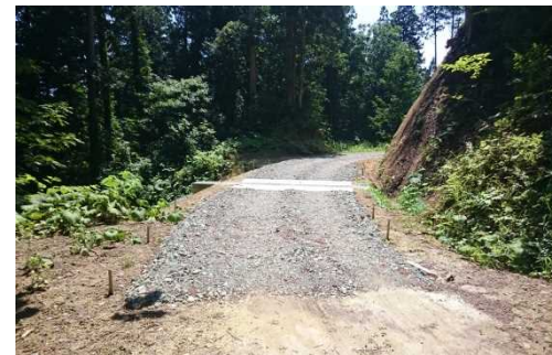
入込山国有林 (ガベヤマ沢林道専用道開設)
