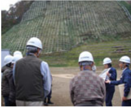
川浪宮城山地災害復旧対策室長による説明 (放森上流治山工事現場にて)
