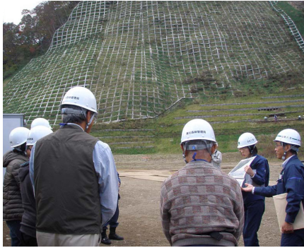
川浪宮城山地災害復旧対策室長による説明 (放森上流治山工事現場にて)
