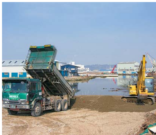
本各復旧工事箇所の状況（東松島市大曲地区）
