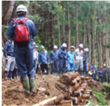
津軽署:森林作業道の丸太組工
