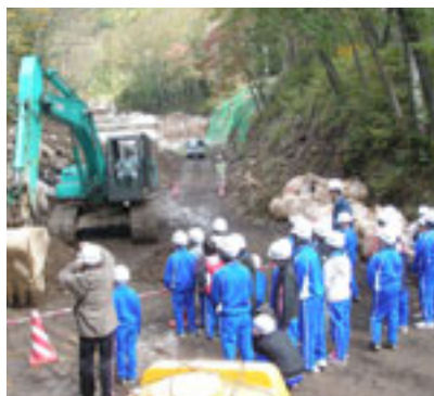
治山工事現場の見学
