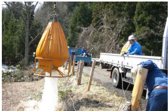
空中消火器散水装置の点検
