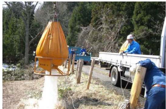
空中消火器散水装置の点検
