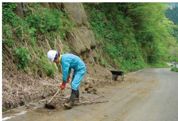
土砂の除去作業
