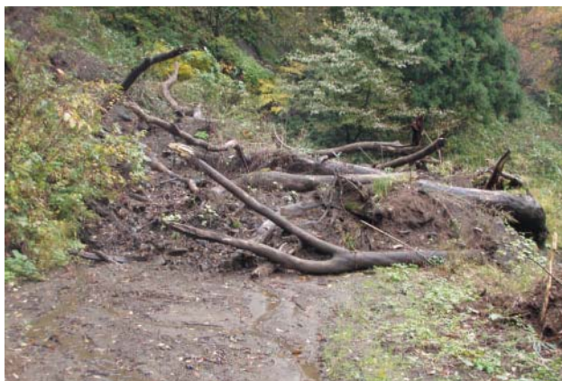
林道上に滑り落ち盛り上がった土砂
