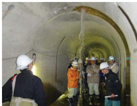
トンネル落込みボーリングの集水状況
