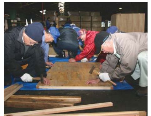
④ 協働によるパーティションユニットの製作
