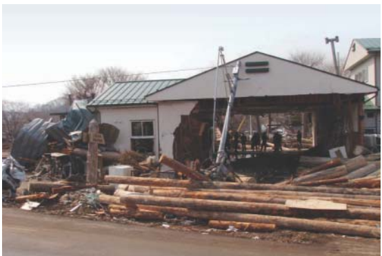
被災した三陸北部森林管理署の庁舎
