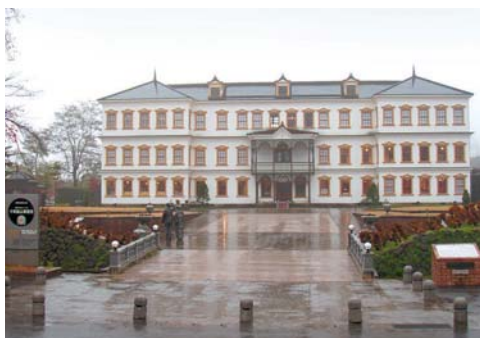
小坂鉱山事務所
