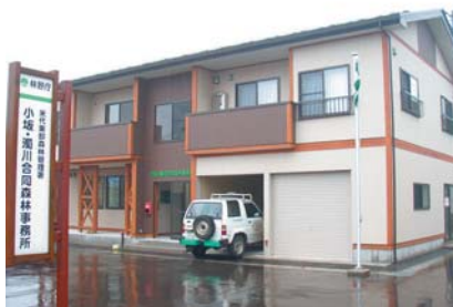
新築された合同森林事務所
