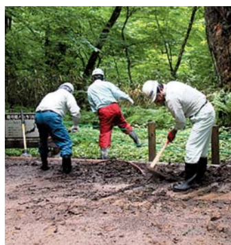
遊歩道の整備
