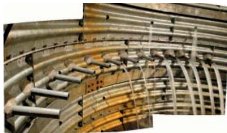
集水井集水ボーリングの集水状況（志津エリアC1ブロック）
