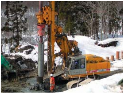
鋼管杭打工施工状況（志津エリアB2ブロック）
