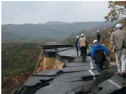
破壊された市道など大規模地すべり地を見学
