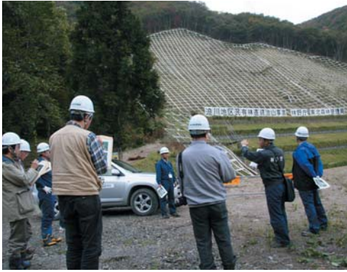
民有林直轄治山事業箇所を見学
