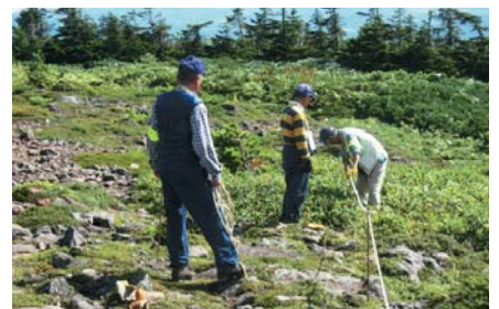
湿原等への踏み込み防止ロープの設置
