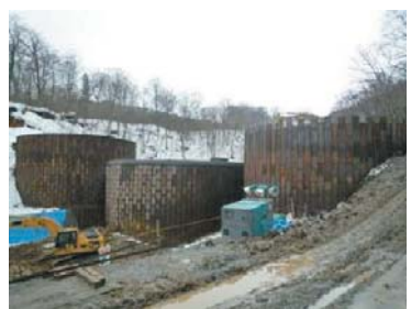
復旧対策工事（岩手県一関市）
