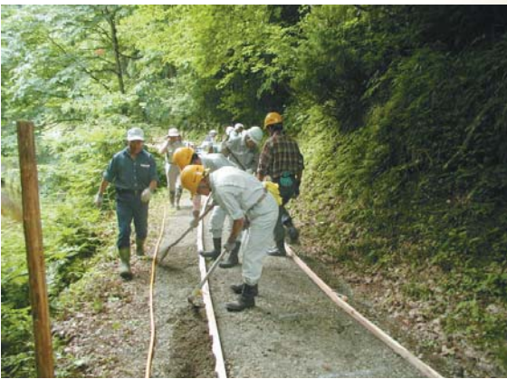
300mのバリアフリー遊歩道を作設
