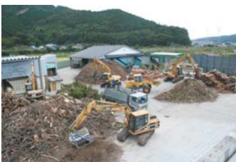
リサイクルセンター全景(石巻森組)
