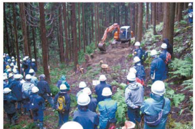
バックホウでの表土ブロック積み工法の実演
