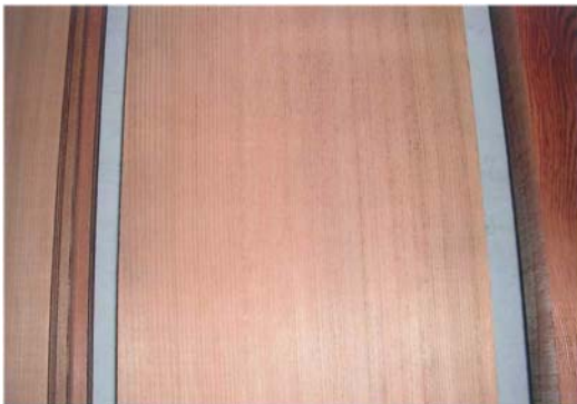
秋田スギの通直な桁天井板
