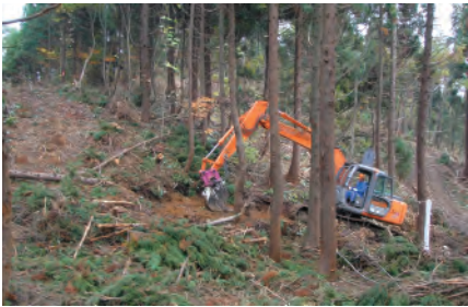
「ザウルスロボ」での作業道作設の実演
