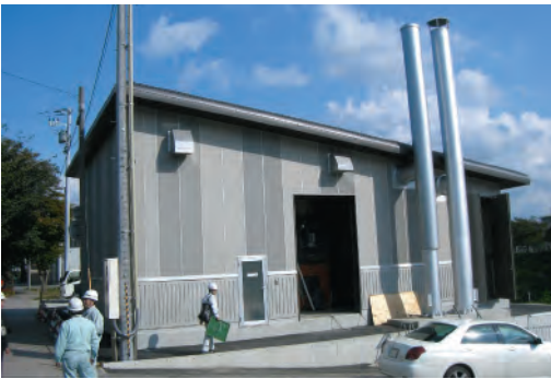
11月から本格稼働する温水供給施設
