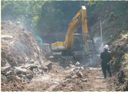
河原小屋沢地区の渓間対策のための資材運搬路の作設
