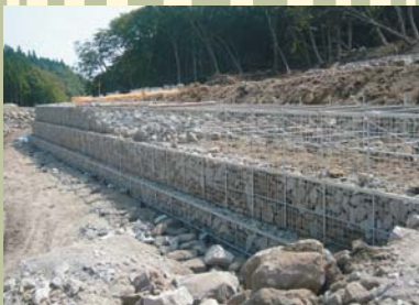
小河原地区の崩壊土砂流出防止のためのカゴ砕土留工
