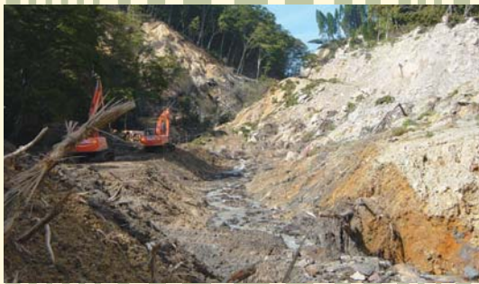
シツミクラ沢地区の河道開削工事
