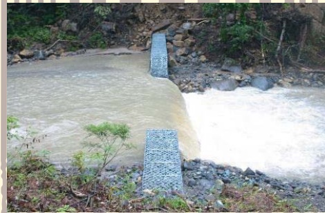
完成したカゴ砕治山ダム工
