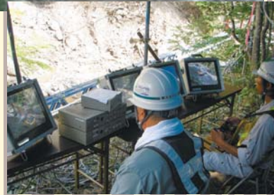
応急対策として尿前川地区に河道開削工事を無線操縦の無人バックホーで実施
