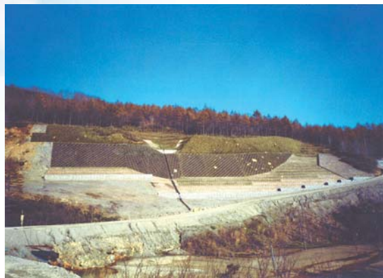
蟹ヶ沢の地すべり工事施工地
