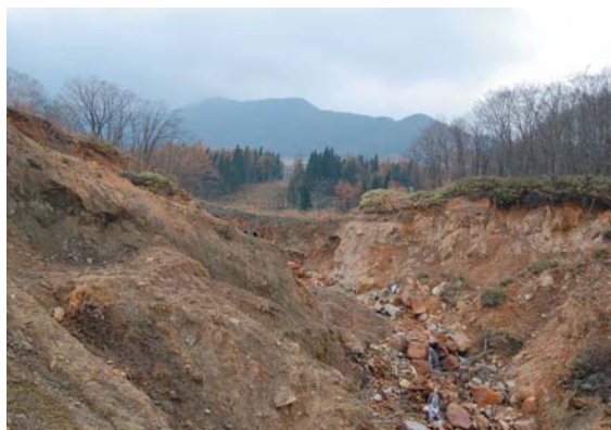
蟹ヶ沢の荒廃状況
