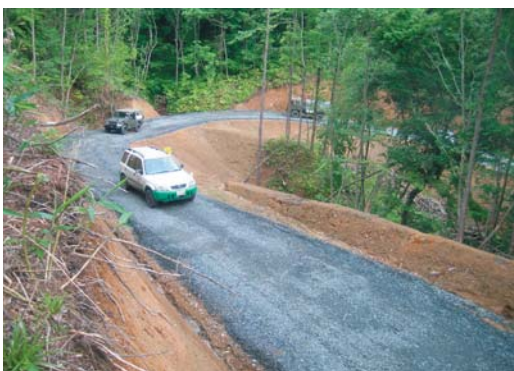
市野乃原地区民直事業地の緊急対策用仮設道（写真右）と国有林林道を供用した迂回路を確保（写真上）（岩手県一関市）
