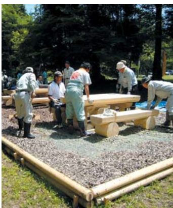
ボランティアの協力により休憩施設を設置
