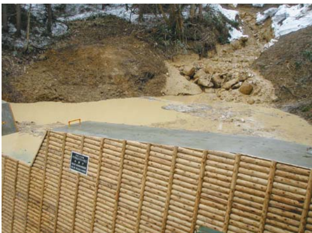
土石流をせき止めて国道を守った治山ダム
