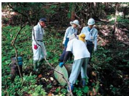
撤去作業を行う参加者
