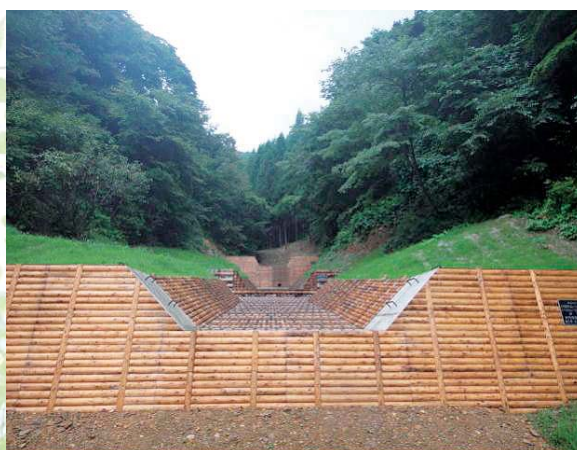
木製型枠を利用した治山工事例（米代西部署）
