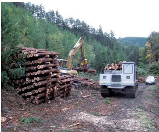
搬出材の積み込み状況（岩手南部署）
