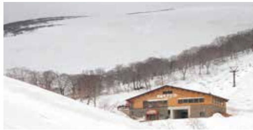
ゲレンデとリフト駅舎
