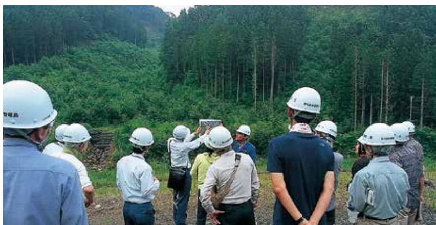
行者滝地区治山工事現場及び説明の様子
