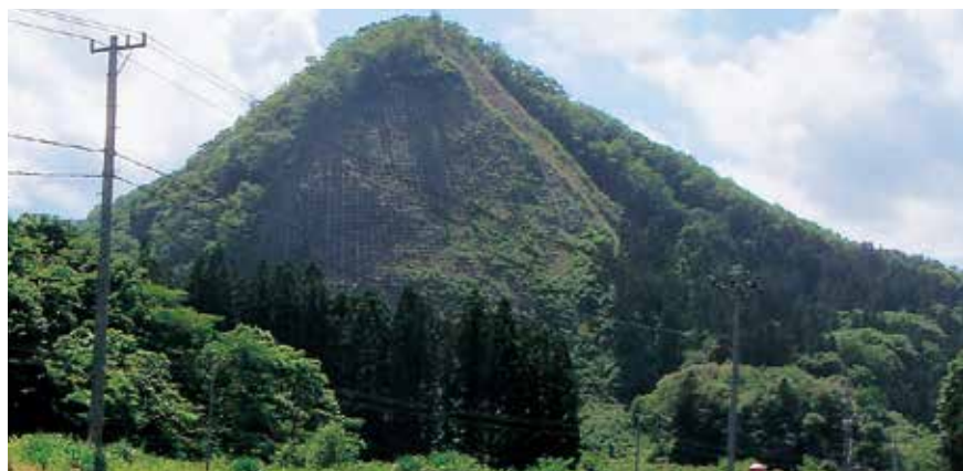
放森地区治山工事現場遠景（のり粹工ほか）
