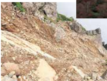
崩壊源頭部の状況
