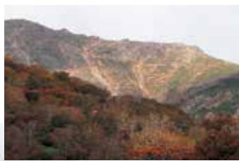
河原の坊コースの崩壊状況遠景
