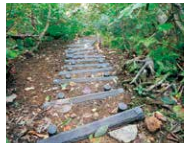
④整備した階段
