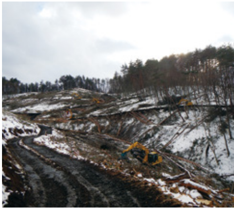
アカマツ樹種転換エリアの皆伐作業
