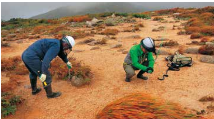
杭・ロープ設置
