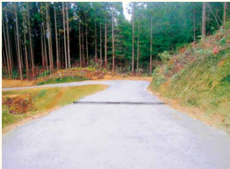
(写真-1) 鉄鋼スラグを活用した簡易舗装
