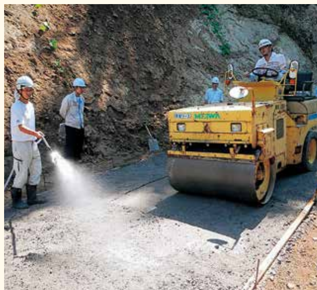
(写真-3) 施工写真 (散水・転圧)
