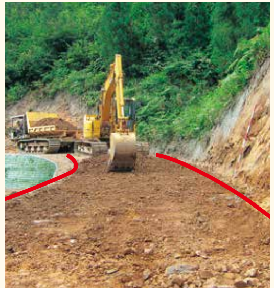
(写真-7) 施工写真 (箱堀)
