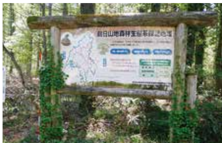
腐朽等が進んだ看板
