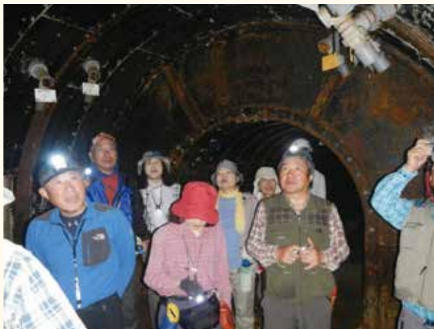
排水トンネル内の見学
