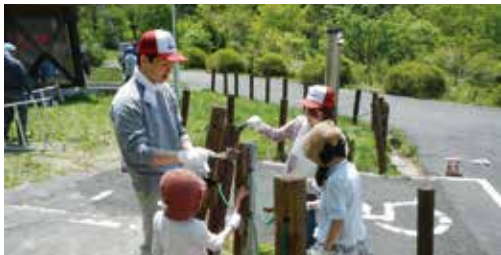
柵柱のペンキ塗り
