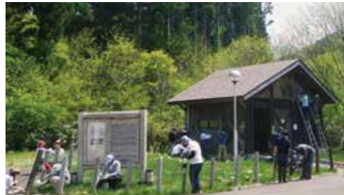
トイレ、看板のペンキ塗り
