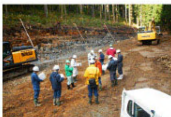
西小又新設工事
