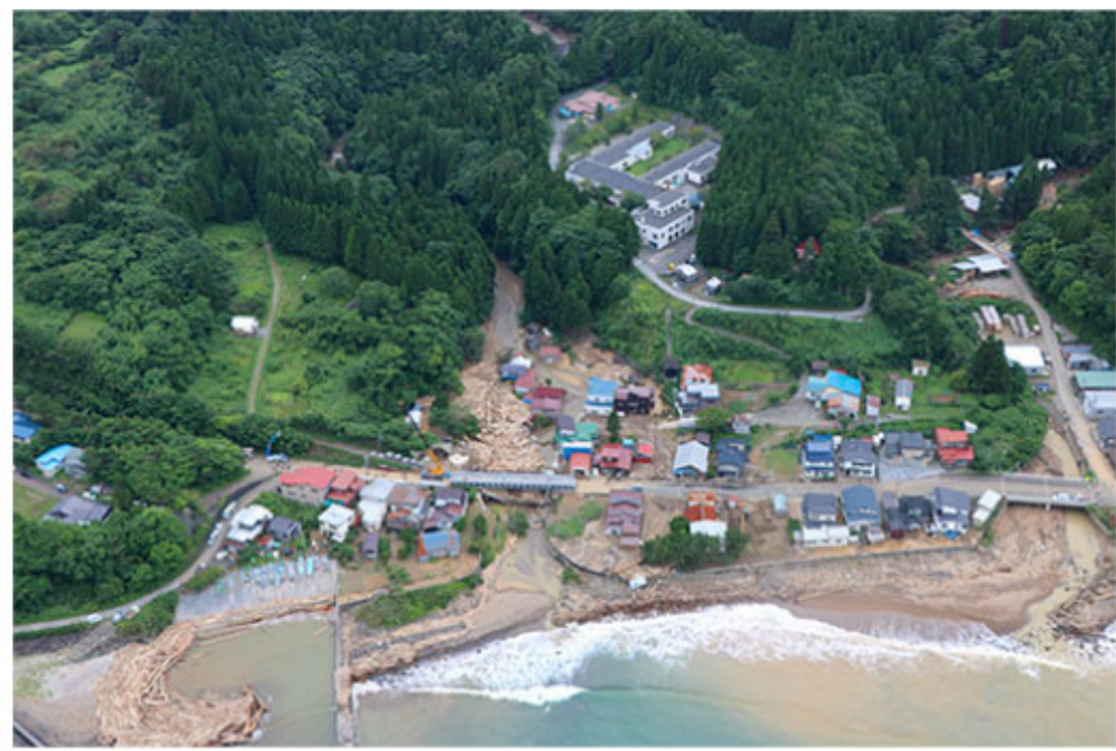
写真1 被災した小赤川橋の流木による閉塞状況
