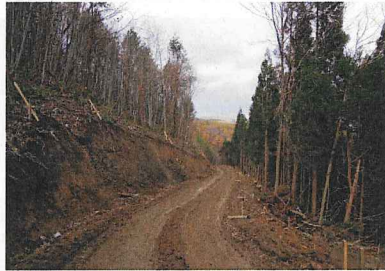
施工中の天望沢林道新設工事（住田町）
