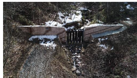
【上野沢治山工事（雫石町）】
