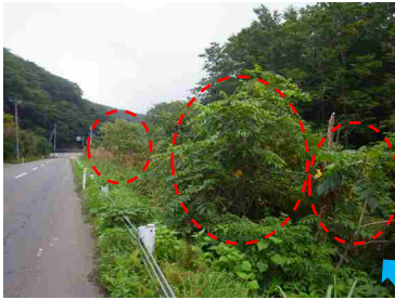
国道347号線沿い法面
